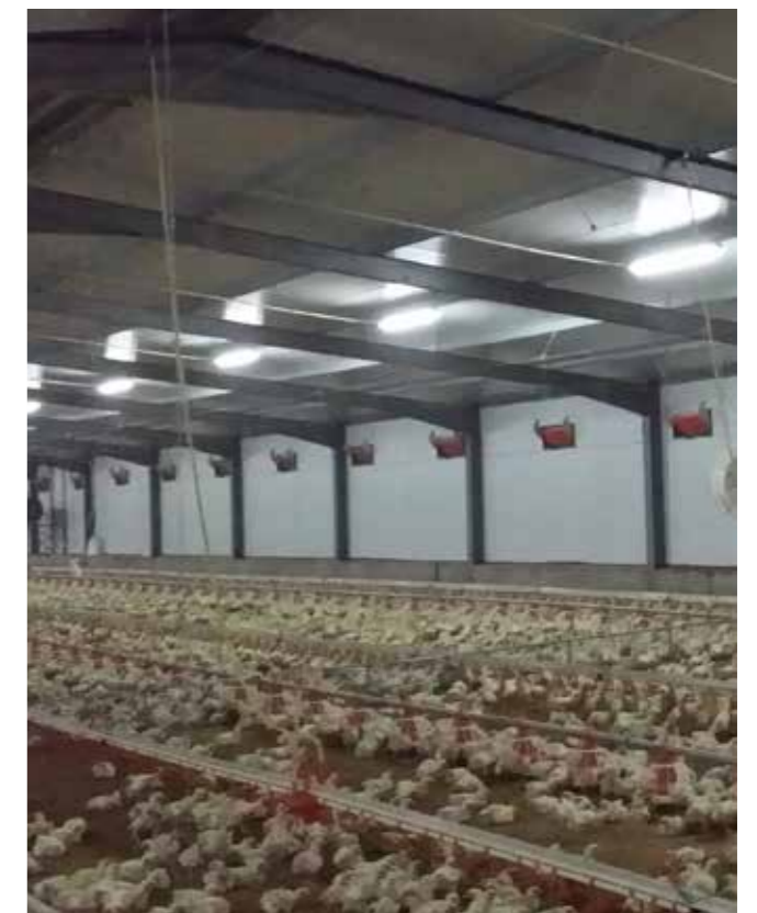
Las trampillas de entrada de aire de un costado.
